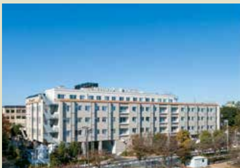
病院3号棟外観
