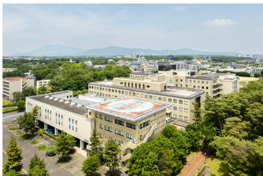
① 筑波メディカルセンター病院
